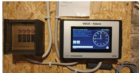
Die neue Uhr ist programmierbar. Sie läuft dank eines Funksignals sekundengenau. Und durch die flexiblen Einstellmöglichkeiten muss der Küster oder ein Vertreter nicht mehr jeden Samstag und an Feiertagen zur Kirche fahren, um die Glocken zu läuten und die Uhr aufzuziehen.
