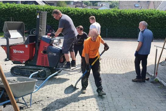
Zuletzt haben freiwillige Helfer mit Schaufel, Schubkarre und einem Dumper mehrere Tonnen Schotter verteilt, die mit einer Rüttelplatte direkt verdichtet wurden. Denn am Rand der Rasenfläche soll eine etwa 20 Quadratmeter große Grillecke entstehen. Zudem soll ein behindertengerechter Weg zur Wiese führen. Als nächstes steht nun das Pflastern dieser Bereiche auf dem Programm. Eventuell sollen Gabionen am Rand noch als weitere Sitzmöglichkeit aufgestellt werden.
